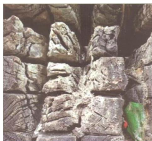
Рисунок 2 – Обвуглена деревина в місці виникнення пожежі
