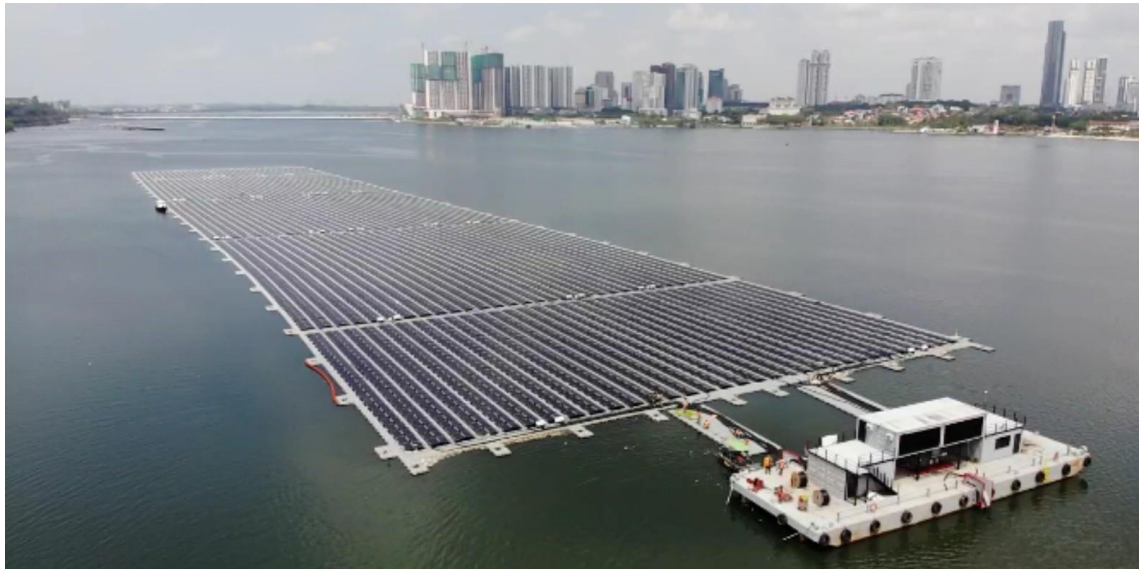
Рис. 2.5. Сонячна ферма оснащена електричними панелями, системами управління і трансформатором
