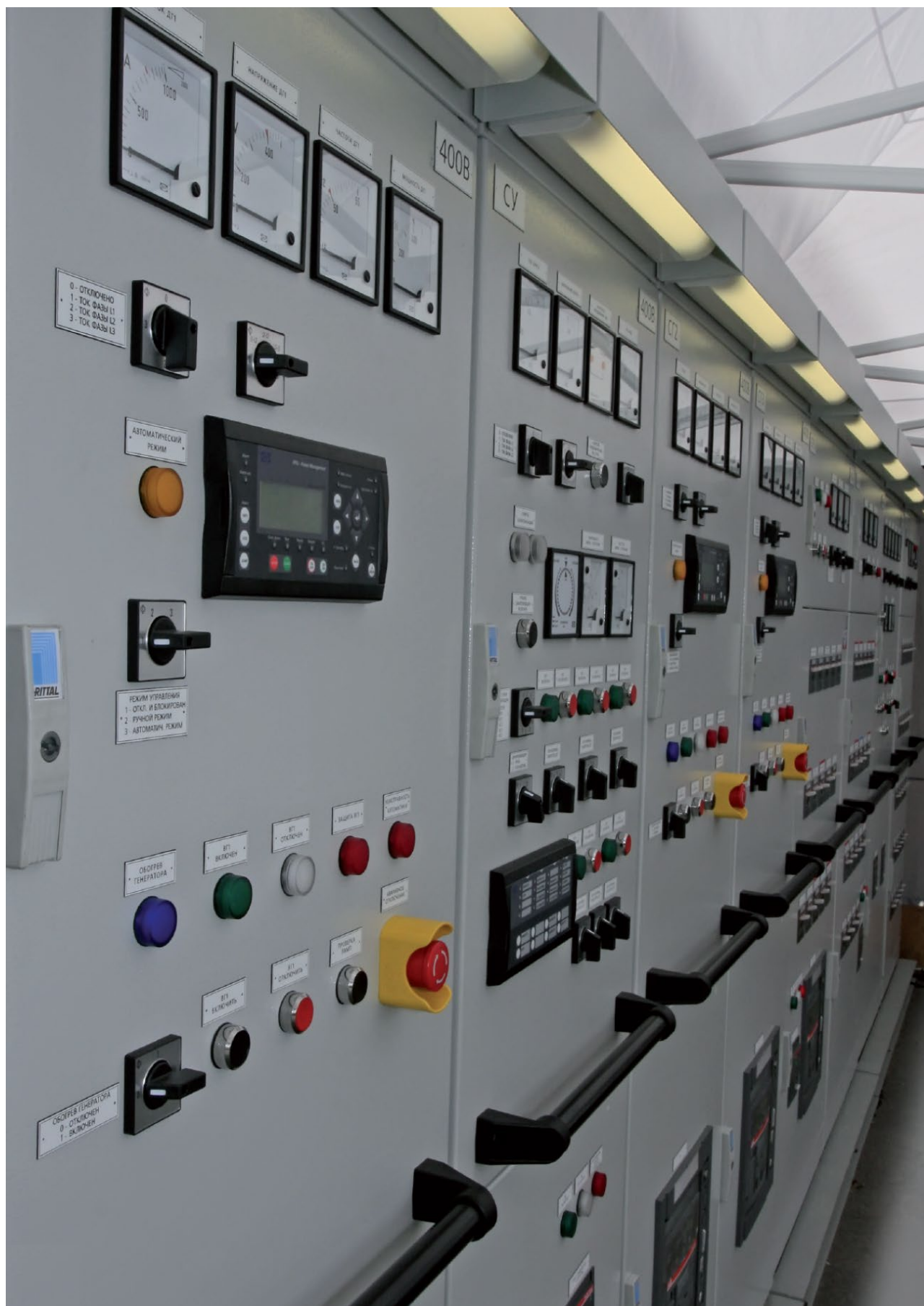
Рисунок 3.17 – ГРЩ судна з контролерами DEIF
