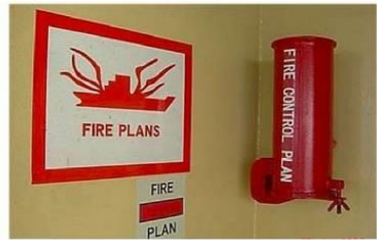
Рис. 4.1. Контейнер зі схемами з протипожежним захистом судна
