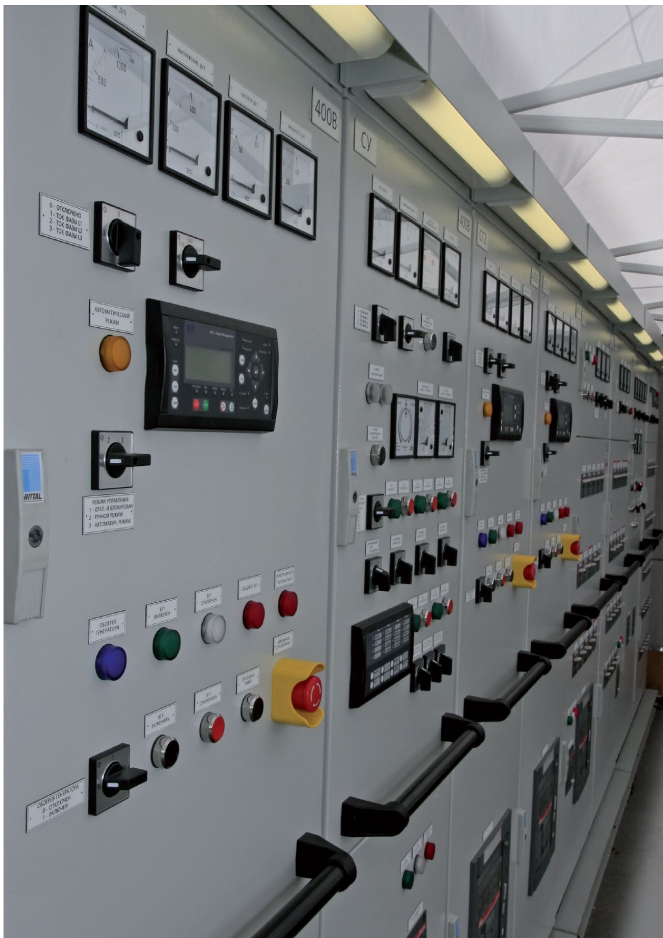
Рисунок 3.17 – ГРЩ судна з контролерами DEIF
