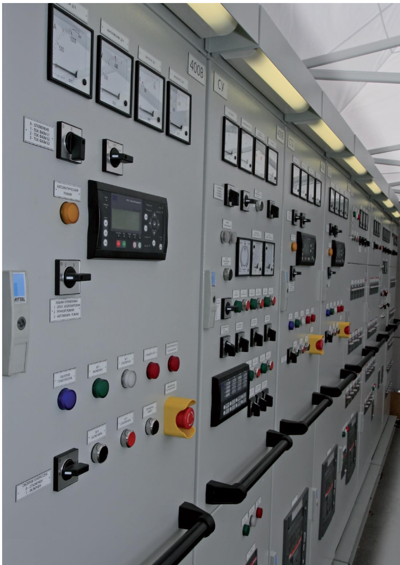
Рисунок 3.17 – ГРЩ судна з контролерами DEIF
